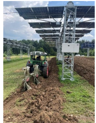
Abb. 6: Technische Bestandteile müssen hoch genug angebracht werden. © ZHAW
