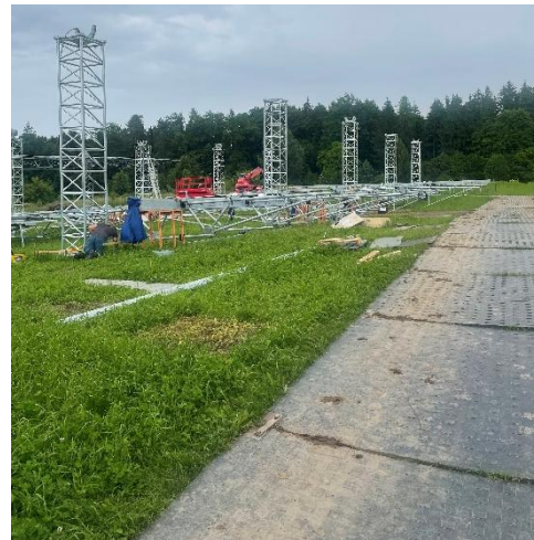
Abb. 5: Spezielle Baggermatten helfen, Bodenverdichtungen zu vermeiden. © ZHAW
